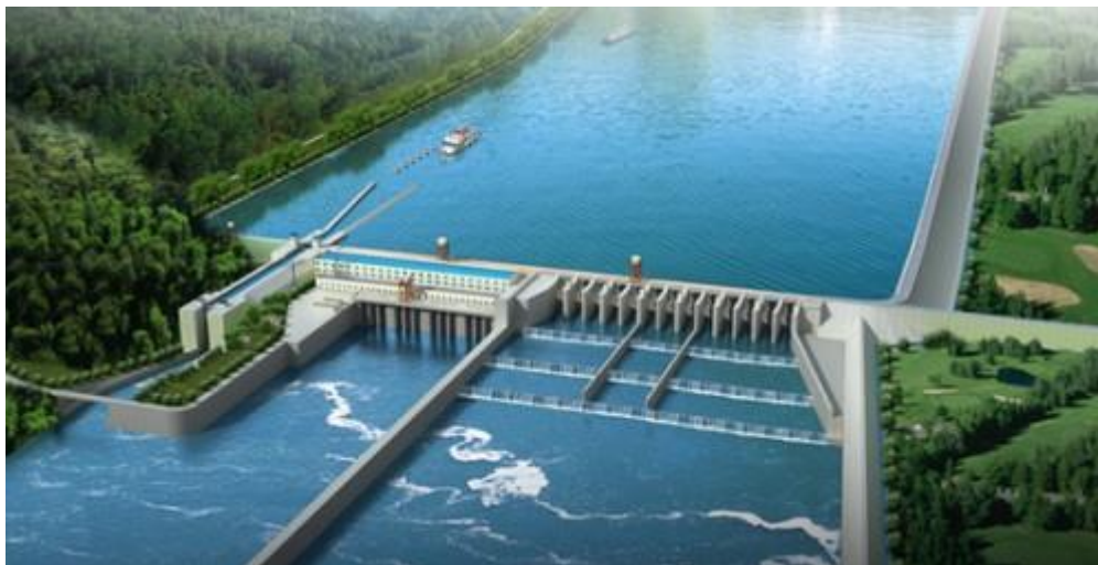
▲ 总投资近 400 亿人民币的大藤峡水利枢纽工程
